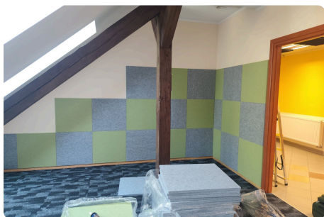
Adaptacja akustyczna w trakcie montażu — panele NexFelt STILLE na ścianach i skosach.
